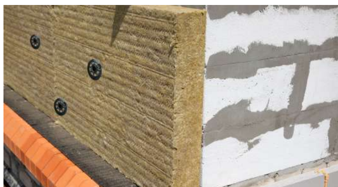
Крепление теплоизоляции к газобетонному основанию
