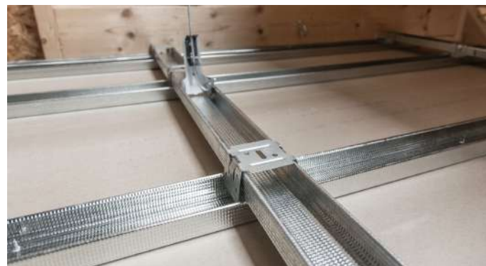
Монтаж соединителя для потолочного профиля
