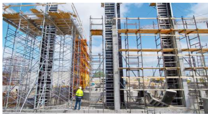
Монолитные работы на строительной площадке
