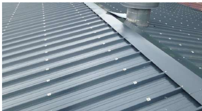
Пристелка профлиста кровли к металлу
