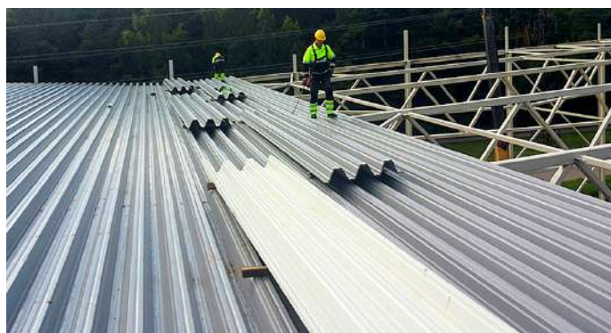
Крепление профнастила
