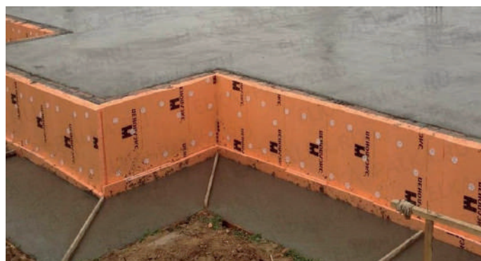
Монтаж пенополистирола
