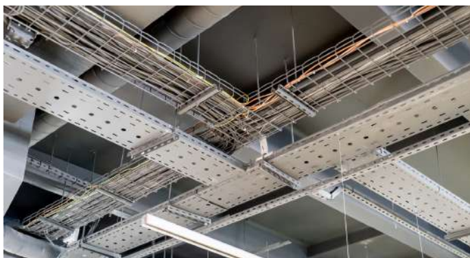
Монтаж кабельных лотков
