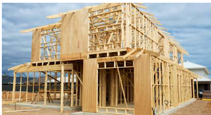
Каркасное строительство
