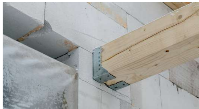
Монтаж закладных деталей
