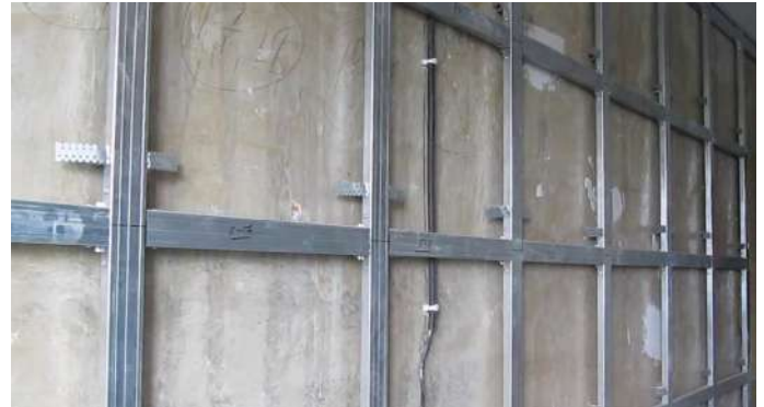
Монтаж гипсокартонных направляющих
