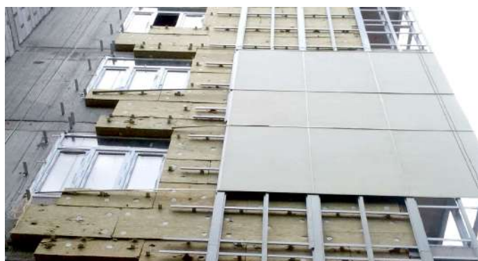
Монтаж теплоизоляции в НФС
