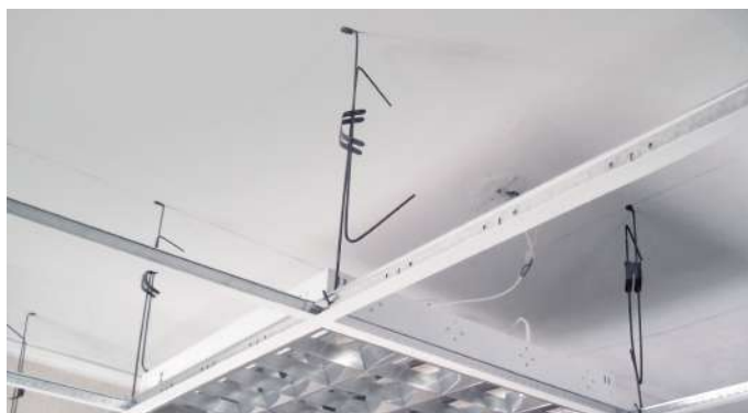
Монтаж подвесного потолка
