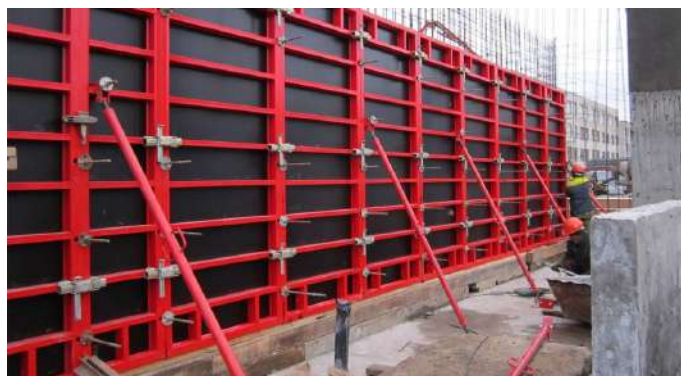
Монтаж опалубки к бетону
