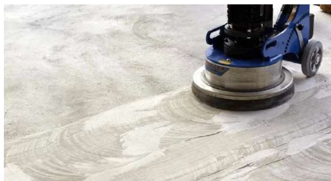
Шлифование бетонного пола
