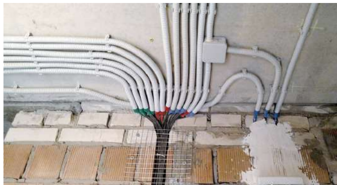
Монтаж электропроводки
