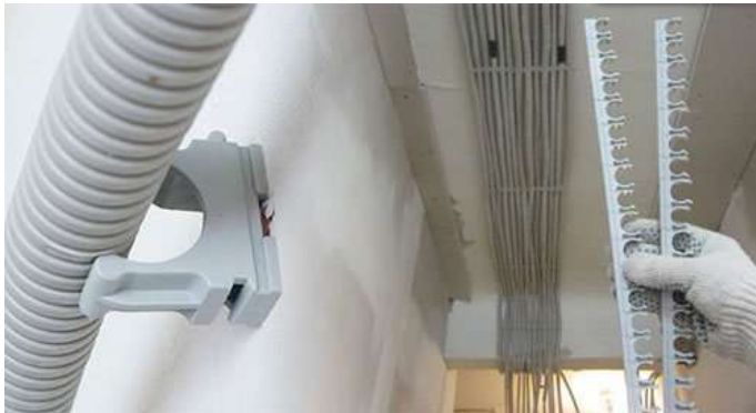
Монтаж пластиковых клипс к бетону
