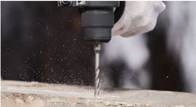
Сверление по бетону
