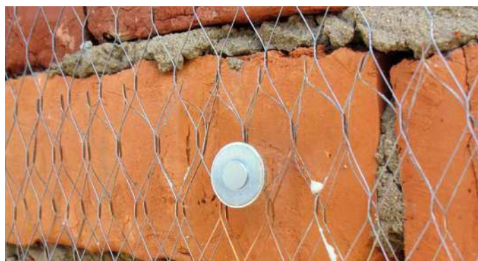
Крепление штукатурной сетки
