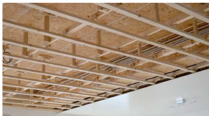
Деревянная обрешетка потолка
