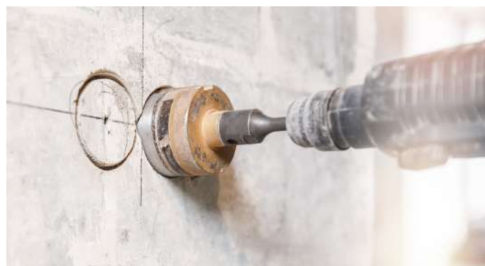
Сверление отверстий для подрозетников
