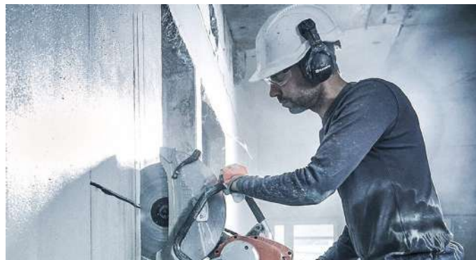
Алмазная резка бетона
