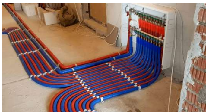
Монтаж труб отопления
