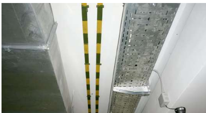
Крепление полосы заземления
