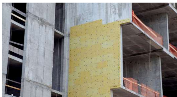
Монтаж теплоизоляции к бетонному основанию
