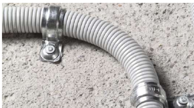
Крепление пластиковой гофротрубы к бетону
